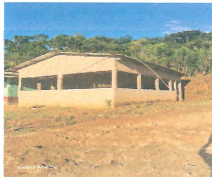
Foto 2: Mejoramiento balcones de la cocina
