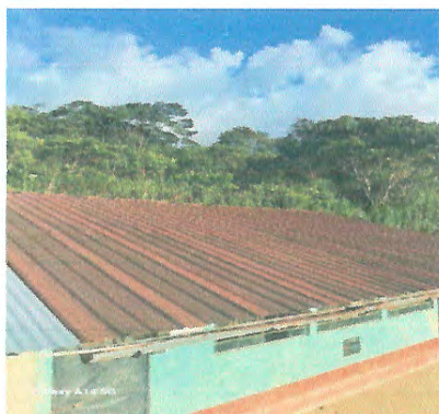
Foto 1: Mejoramiento cubierto de lamina
